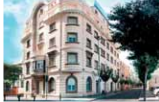
Hospital de Montserrat
